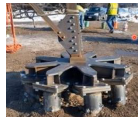
Mecanização no processo de Execução das Fundações
