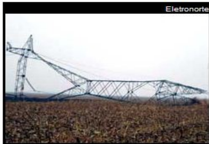
Uma das torres que caíram na tarde de quinta-feira em razão de atos de vandalismo em Lucas do Rio Verde
